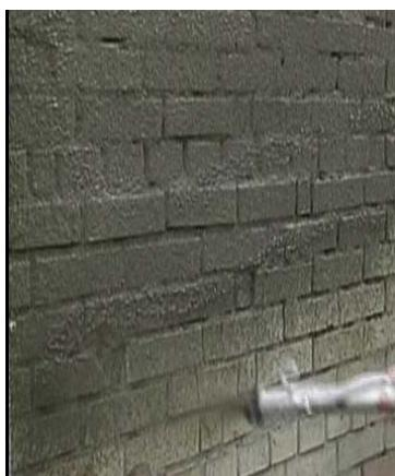
Цементный обрызг Baumit Spritz 2 мм применяется для укрепления, повышения адгезии и выравнивания впитывающей способности оснований с последующим нанесением выравнивающих штукатурных слоев Baumit. Baumit Spritz не используется в качестве выравнивающего слоя.
