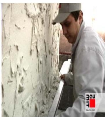
Для оштукатуривания наружных и внутренних стен применяется облегченная штукатурная смесь на сером цементе с добавками перлита Baumit MPA 35L. Специальный продукт для оснований из пенополистирольных блоков и пустотелых керамических блоков (типа Porotherm).
